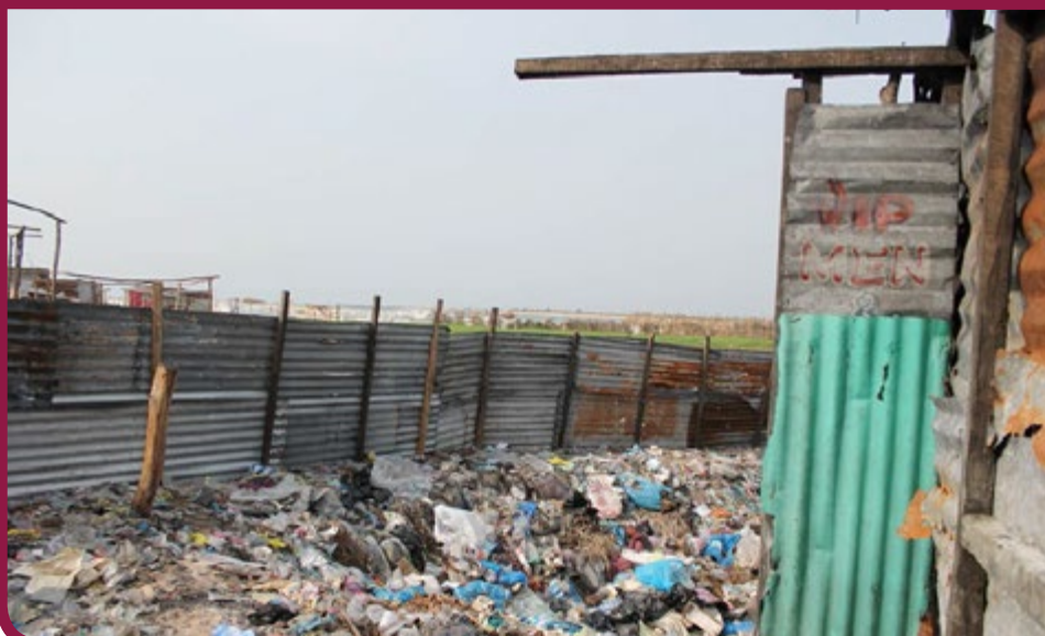
Des latrines à West Point, Monrovia. Photo: Rehana Merali (2014)
