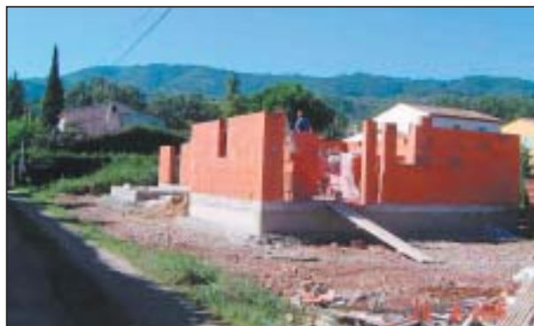
Exemple de disposition constructive en zone inondable : surélévation du premier plancher d'habitation
