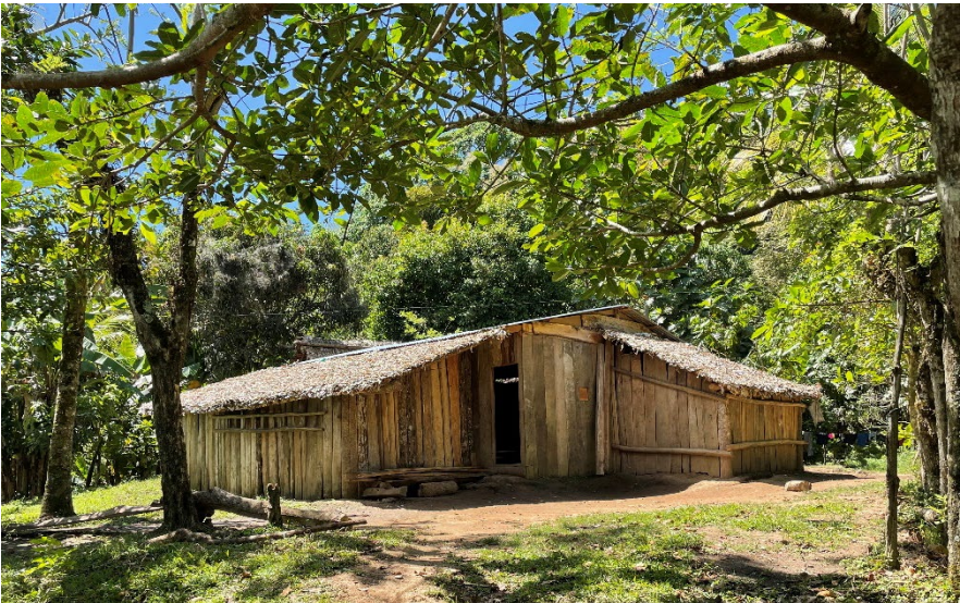
En algunos casos, el zinc se utilizó para cubrir la casa principal y los anexos se cubrieron con palmas
