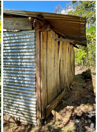
A menudo se reutilizó la madera de la casa anterior; las láminas de zinc a veces también sirvieron para proteger paredes expuestas
