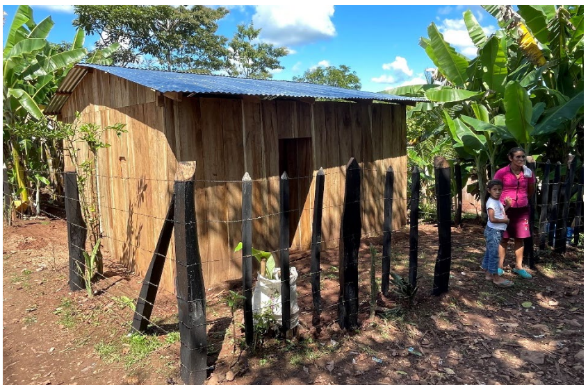
Las 12 láminas de zinc distribuidas fueron casi siempre suficientes para reconstruir los techos. Las familias beneficiarias tuvieron que conseguir la madera.
