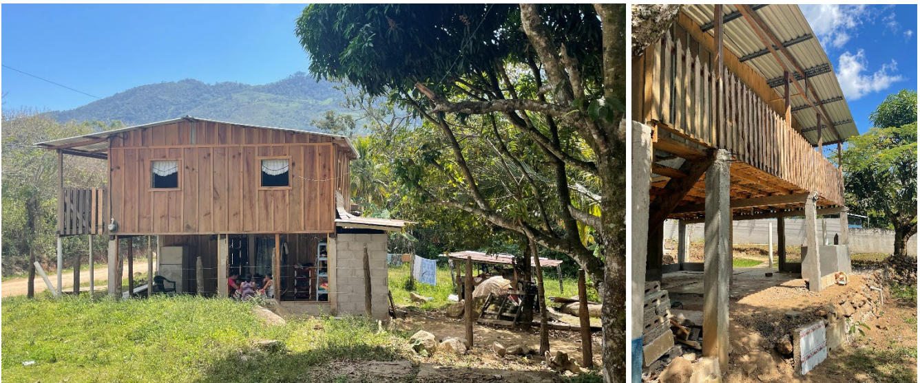
Las casas se construyeron conforme a técnicas y tradiciones locales. A menudo, las construcciones no son resistentes a los desastres.
