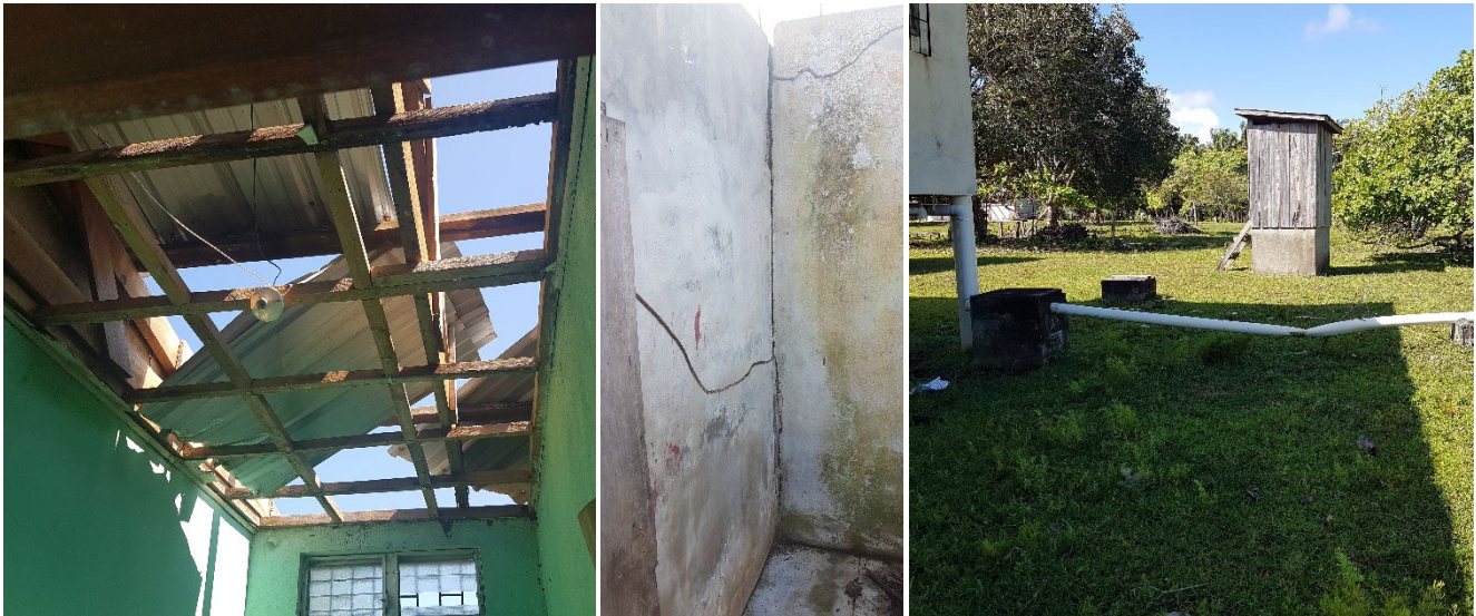
Daños en edificios (techos, paredes, ventanas y puertas) y en los sistemas de suministro de agua (recogida de agua de lluvia, tanques de agua, tuberías.)
