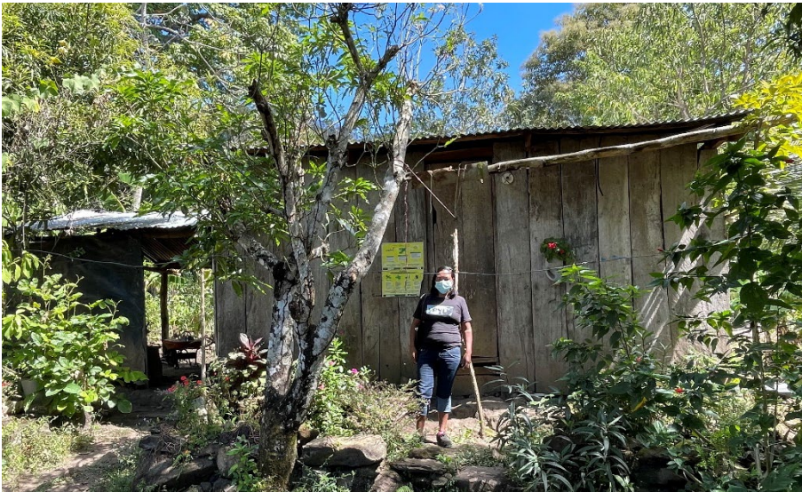
A menudo se reutilizó la madera de la casa anterior; las láminas de zinc a veces también sirvieron para proteger paredes expuestas
