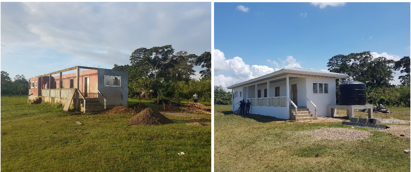
Centro de Salud de Lakunka: antes y después de las reparaciones
