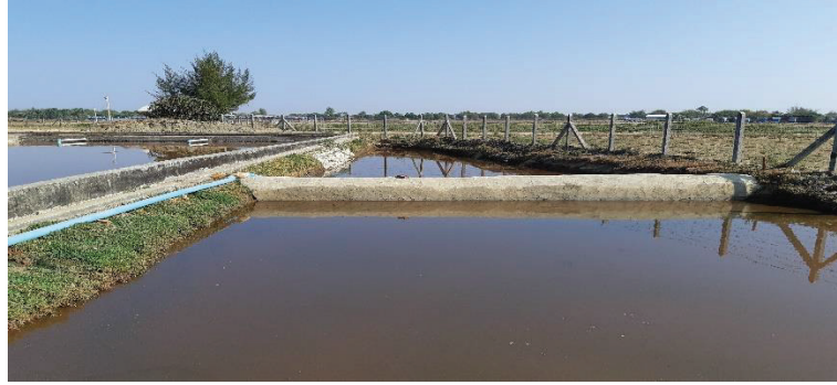
ပုံ ၂၃ - ရေစိမ့်ဝင်သည့်ကန်များ (ပြည့်နေစဉ်)
