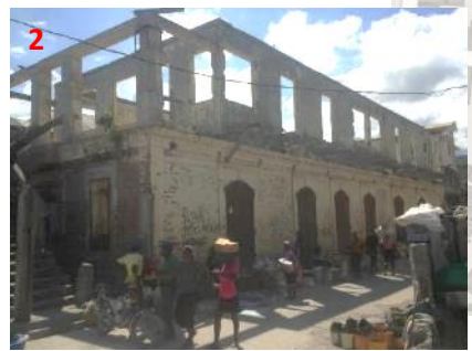
2 - Ancien bâtiment de la Douane
